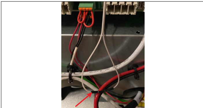
Fig. 108 Mazo del puente J1
